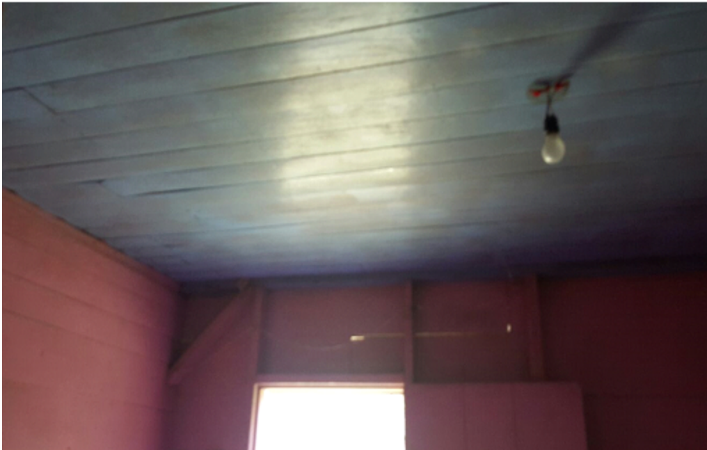
Fotografía # 12 Vista interna: Cielo raso de tabla y paredes de madera a un sólo forro
