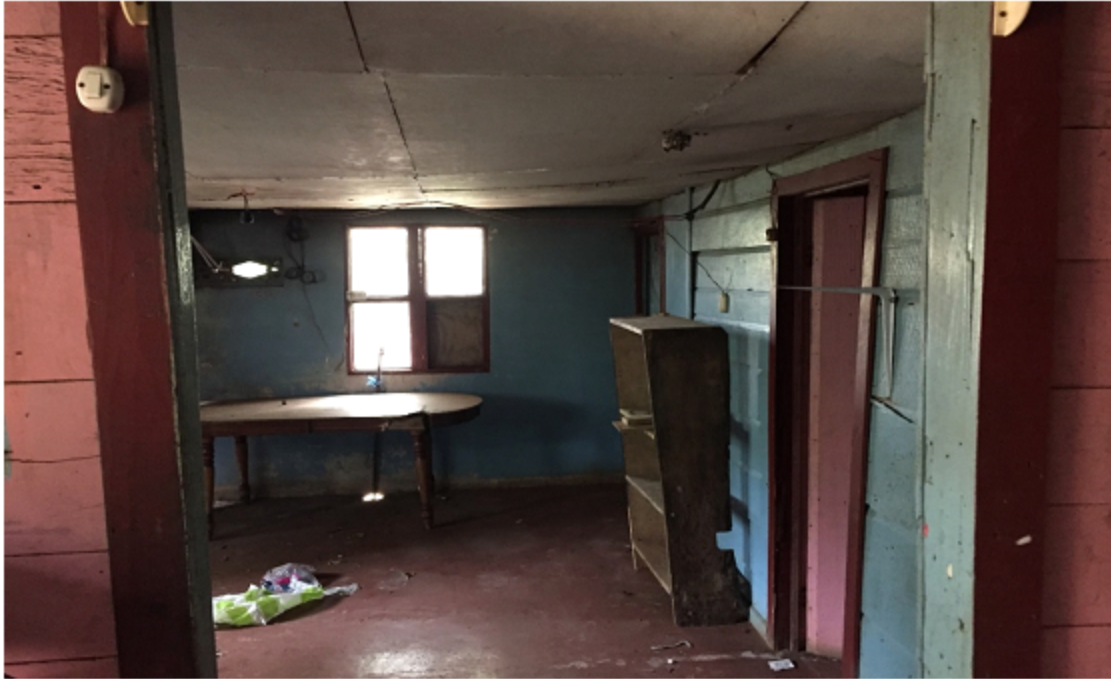
Fotografía # 11 Vista interna: Piso y paredes de madera a un sólo forro
